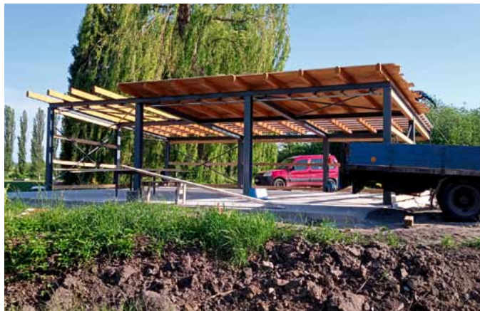
Stavba venkovní učebny – Základní škola Sobotka
