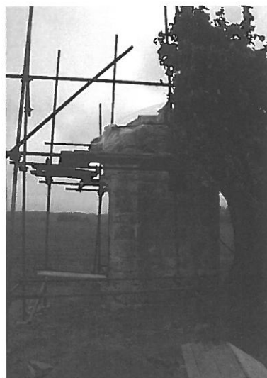
Z průběhu oprav kapličky u Lavic v září a říjnu 2013, pohled od hlavní silnice.
