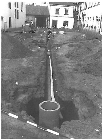
Malé náměstí v probíhající rekonstrukci.
