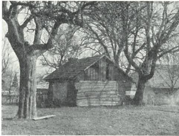
Sušárna vynášečka v Ohařicích č. 9
